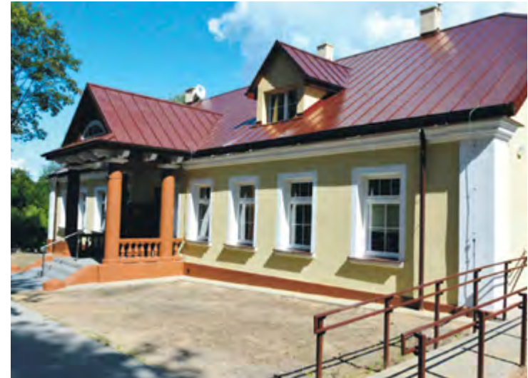
Wyremontowany budynek Warsztatów Terapii Zajęciowej
