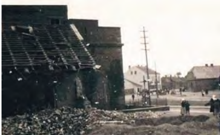
Zniszczony bombą budynek na rogu ulic Okulickiego i Główniej
