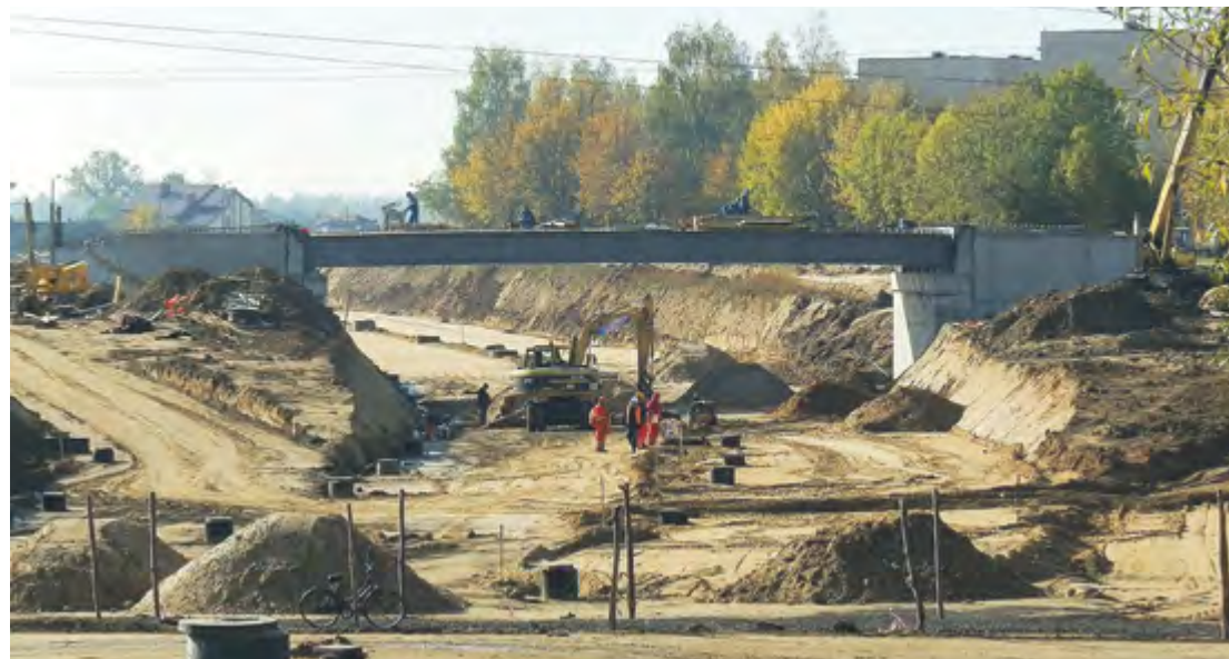
Tak powstał pierwszy etap obwodnicy południowej Radomia w rejonie Prędocinka
